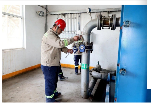
开展磨机检修 维护设备安全
